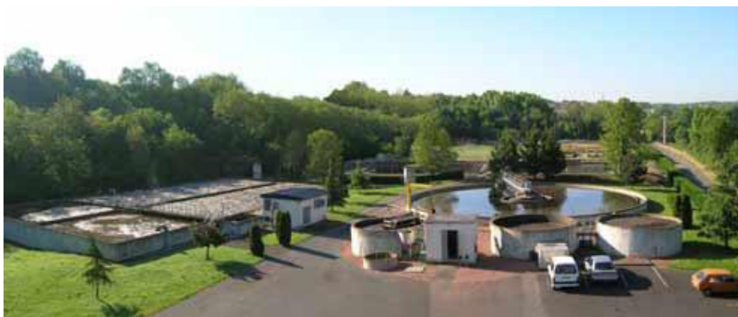
Station d'épuration de Sainte-Verge (Crédit photo : Communauté de Communes du Thouarsais).
